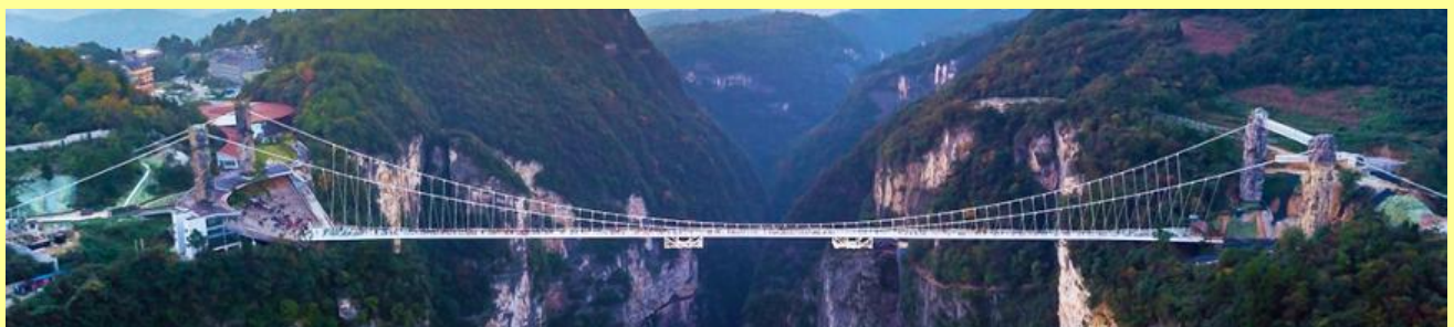
สะพานกระจากข้ามหุบเขาเกรนดี้แคนยอน
