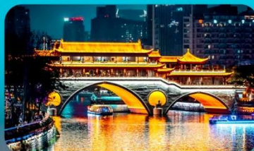
สะพานอันชุน
